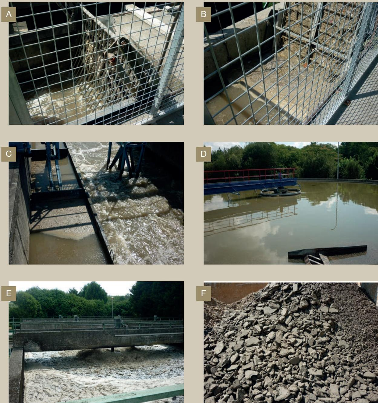
**FIGURA 2:** Ejemplos de algunos procesos del tratamiento de las EDAR. Reja de desbaste de sólidos gruesos (A), tamiz de desbaste de sólidos finos (B), canal desarenador-desengrasador a la izquierda de la imagen (C), decantador primario (D), reactor biológico de fangos activos (E). Resultado final del tratamiento de lodos: fango deshidratado (F).
