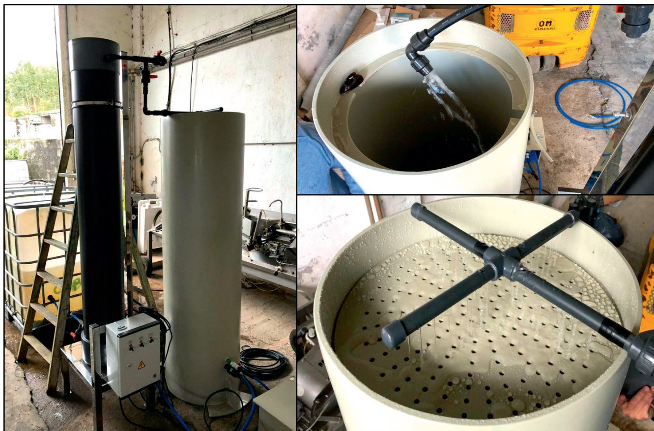
Fig. 7. Diversas fotografías del proceso de montaje del sistema piloto de desnitrificación/nitrificación en la planta de acuicultura.
